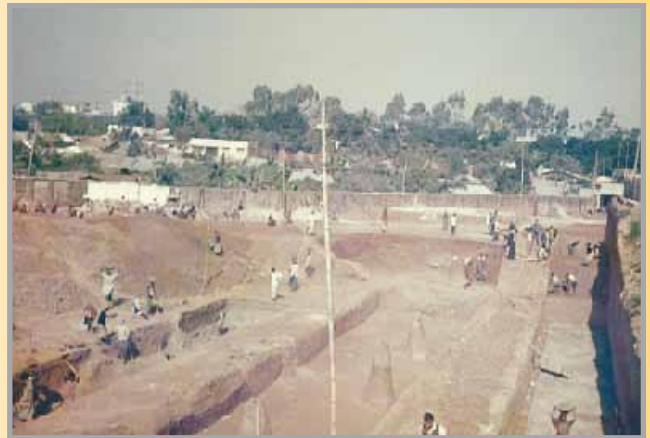
নির্মাণ কাজের প্রাথমিক পর্যায়ে : ভূমি থেকে ৩০ ফুট নিচে খনন কাজ চলছে (জানুয়ারি ১৯৯৪)
